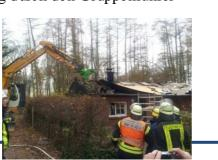
Feuerwehr soweit abgelöscht. waren hinter einem Dachgiebel und unter der Dachabdeckung noch Schwelbrände. Die Aufgabe der FGr R war es nun, mit dem Sortiergreifer einen Teil der Dachhaut dann den entfernen. Giebel niederzulegen um die schwelende Isoliermasse zu entfernen. Durch das Entfernen der Dachhaut konnte die Feuerwehr sodann per Drehleiter weitere Glutnester auf dem Dachboden ablöschen. Das Ablöschen geschah teilweise mit Schaumzusatz.
