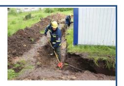
(FGr R) aus Münster unterstützen und das bereits vorhandene Leerrohr freilegen, um einen neuen Zugang zu schaffen, da das Leerrohr wohl bei anderen Baumaßnahmen beschädigt worden war. Zudem erschwerten der Regen und der hohe Grundwasserpegel die Arbeiten, so dass teilweise mit Wathosen in den Gräben gearbeitet werden musste.
